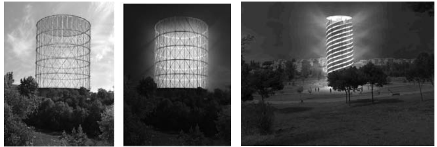
Fig. 8 – Esempi di dispositivi fotovoltaici come elementi architettonici e di design
